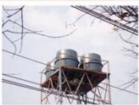
ซ่อมแซมถังเก็บน้ำประปา ม.7
