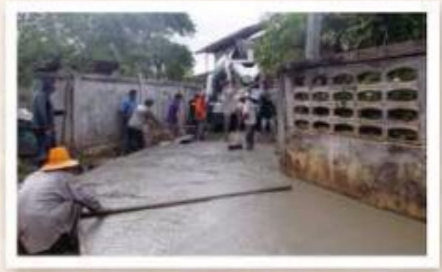
ก่อสร้างถนน คสล ม.4 ซอยบ้านผู้พันนิเวศ
