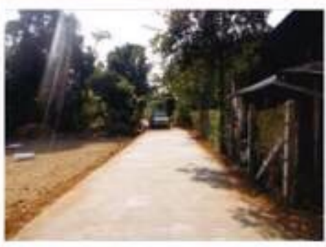
ก่อสร้างถนน คสล ม.5 ซอยบ้านนายแตง
