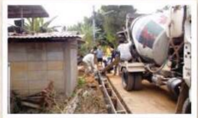
ก่อสร้างรางระบายน้ำ ม.2 ซอยบ้านนางบุญมี
