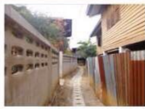
ก่อสร้างรางระบายน้ำ ม.1 จำนวน 2 จุด
