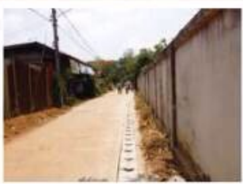
ก่อสร้างรางระบายน้ำ ม.8 ซอยประทุมมาศ
