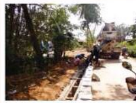
ก่อสร้างรางระบายน้ำ ม. 2 ซอยต้นขาม - คลองควาย
