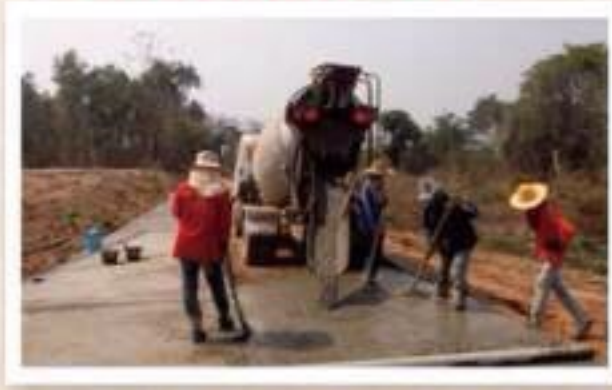
ก่อสร้างถนน คสล ทางเข้าสนามกีฬา ม.1
