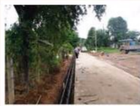
ก่อสร้างรางระบายน้ำ ม.10
