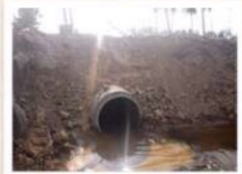
วางท่อคอนกรีต ม.9
