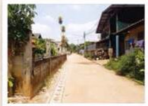
ก่อสร้างรางระบายน้ำ ม.8 ซอยคุ้ม 5 ทานตะวัน
