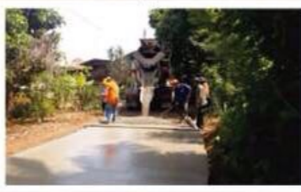
ก่อสร้างถนน คสล ม.4 ซอยศรีดอยไชย์
