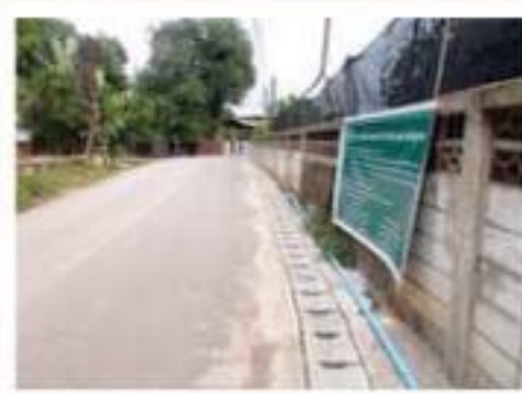
ก่อสร้างรางระบายน้ำ ม.9 จำนวน 3 จุด
